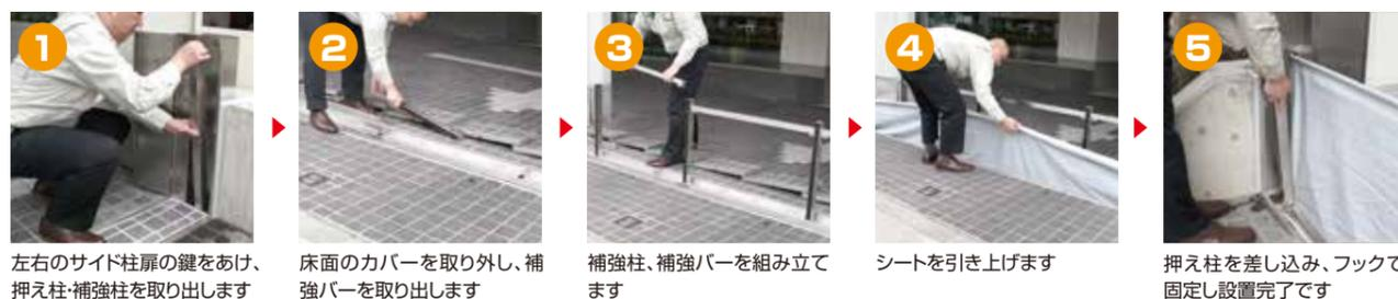
1 左右のサイド柱扉の鍵をあけ、押え柱・補強柱を取り出します
